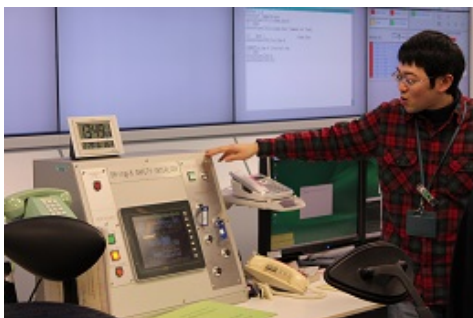
非常に重要なスイッチ
