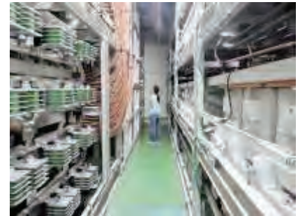
国内最大のコンデンサーバンク
